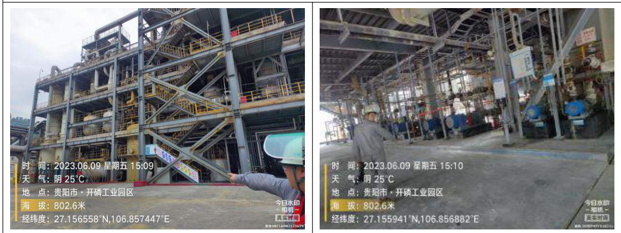
生产区（外部、内部）现场照片
