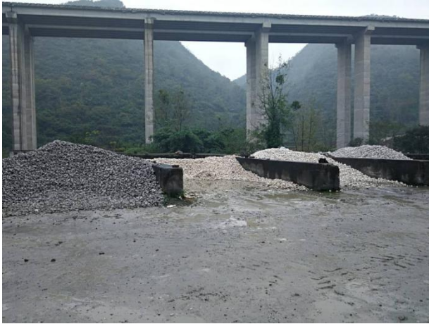
项目碎石堆放点
