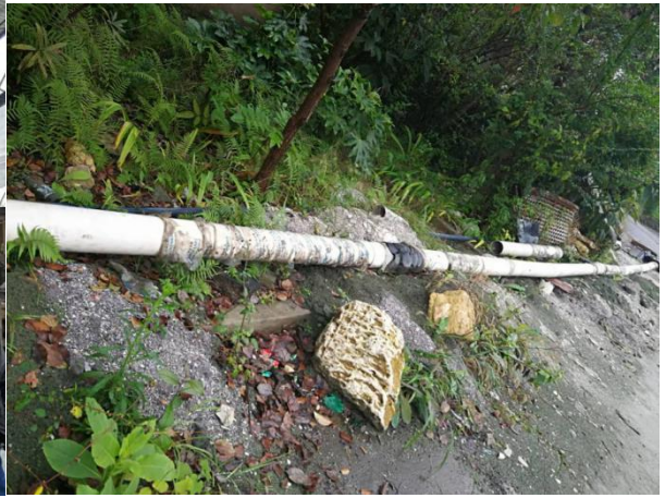
生产废水管道
