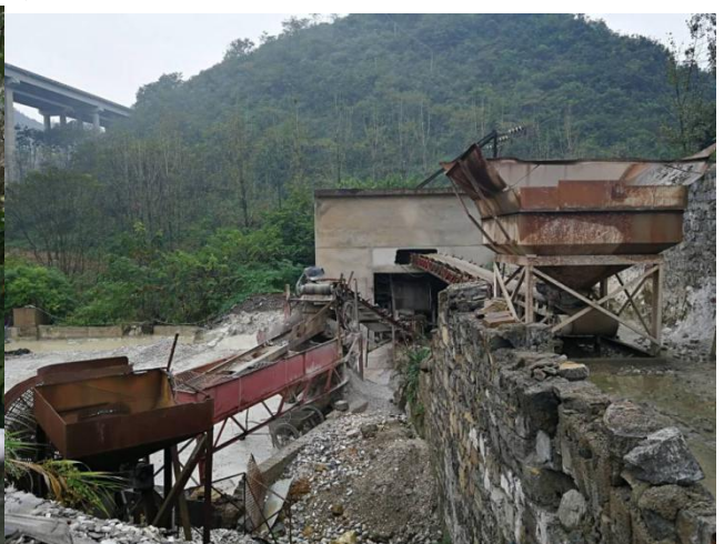
项目边磨机及沉淀池
